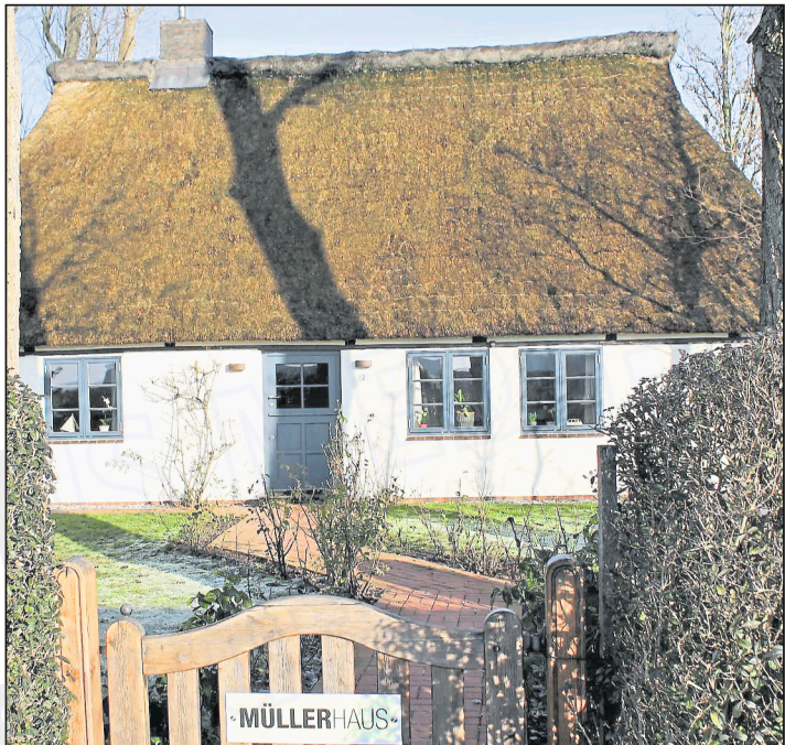
Das Müllerhaus erstrahlt in neuem Glanz.
